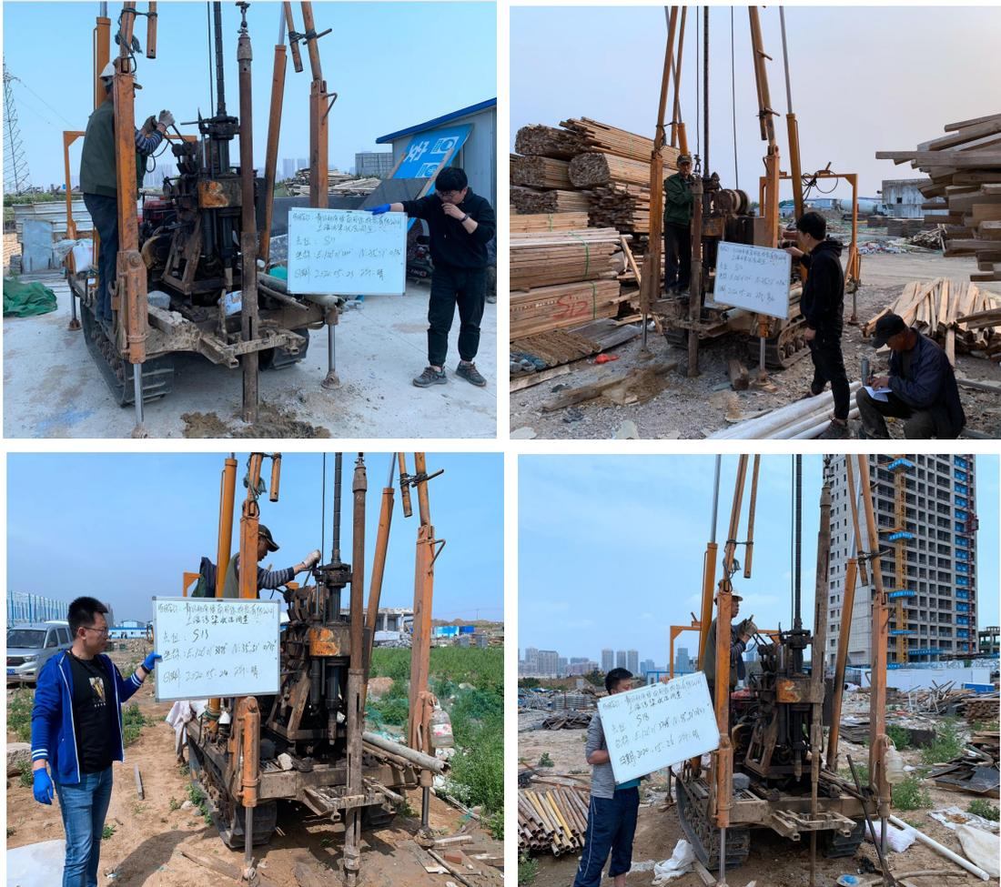
图 5-2 现场钻探照片
