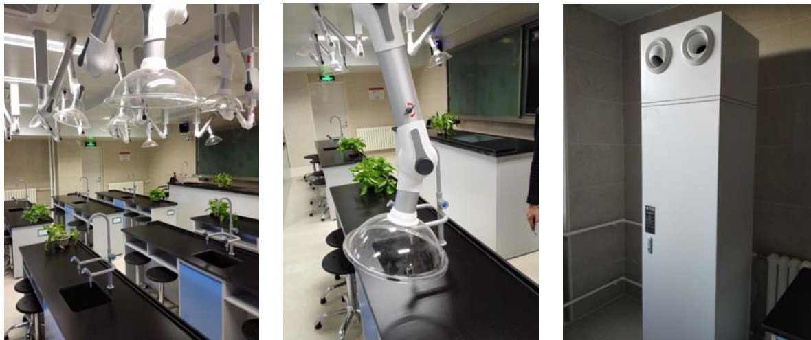
化学及生物实验室废气收集系统
